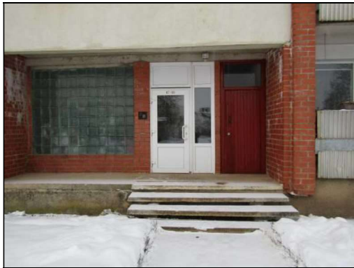
Skats uz kāpņu telpas ārdurvīm
