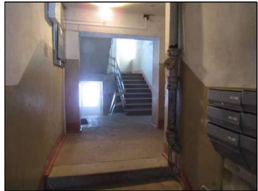
Skats uz kāpņu telpu
