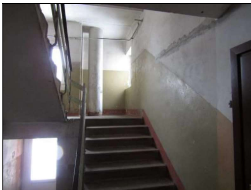
Skats uz kāpņu telpu
